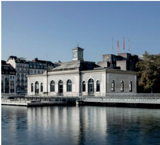
FHH, Pont de la Machine 1, Genève
